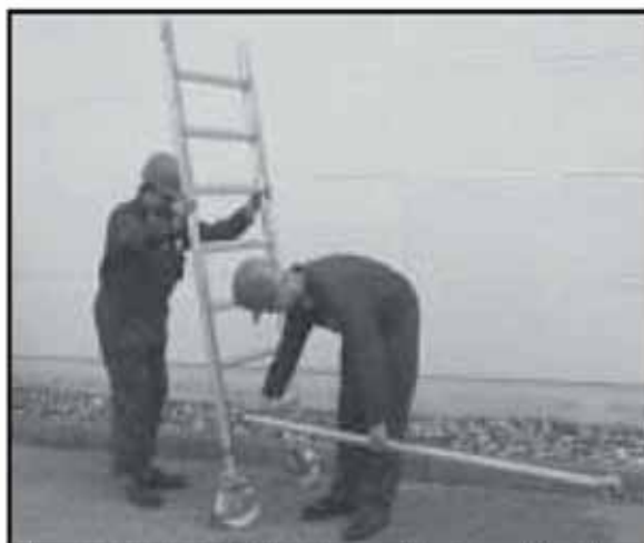
Obr. 15 Montážní nastavení horizontálních vzpěr
