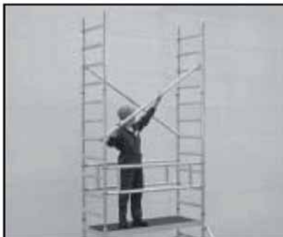
Obr. 25 Montáž diagonálních vzpěr
