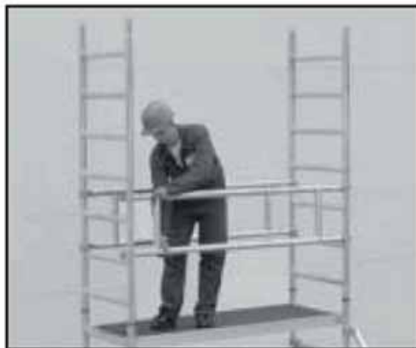
Obr. 23 Montáž zábradlí
