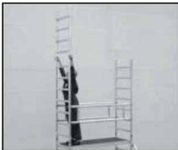
Obr. 24 Nasazení nasazovacího rámu
