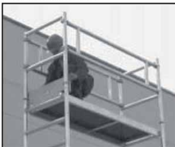
Obr. 29 Montáž příčné zástěny
