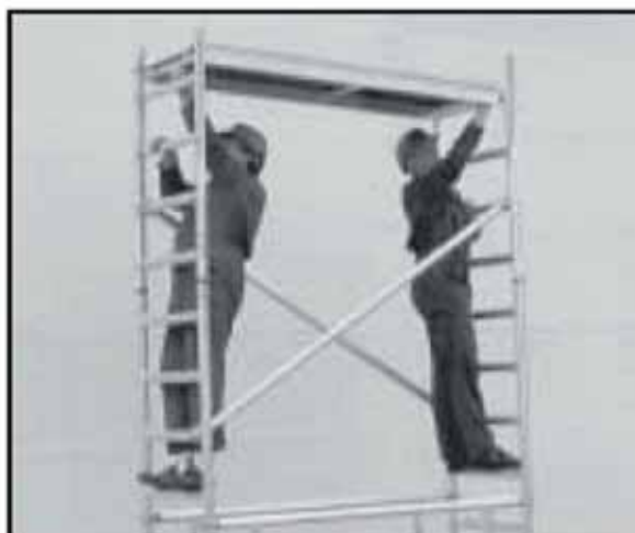
Obr. 26 Montážní nastavení plošiny
