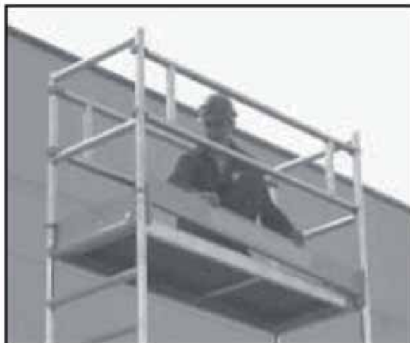
Obr. 30 Montáž podélné zástěny
