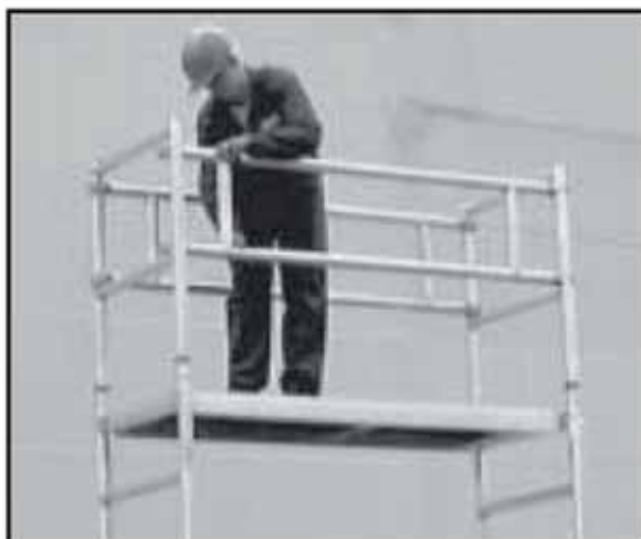
Obr. 28 Montáž zábradlí
