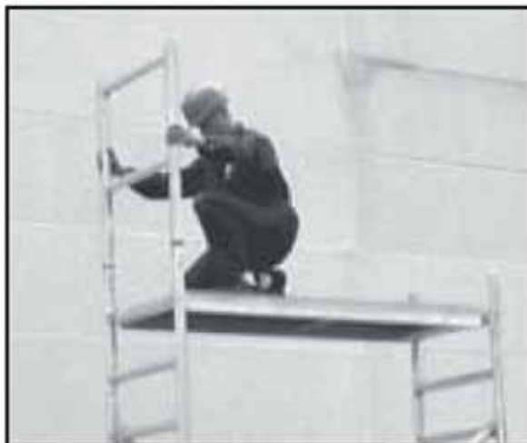
Obr. 27 Montáž rámu zábradlí
