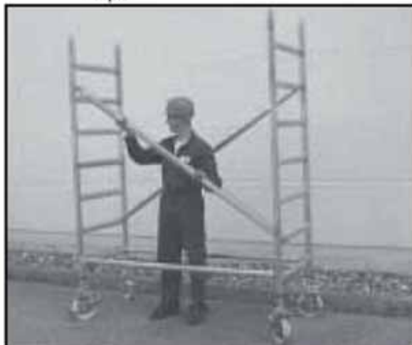
Obr. 16 Montážní nastavení diagonálních vzpěr
