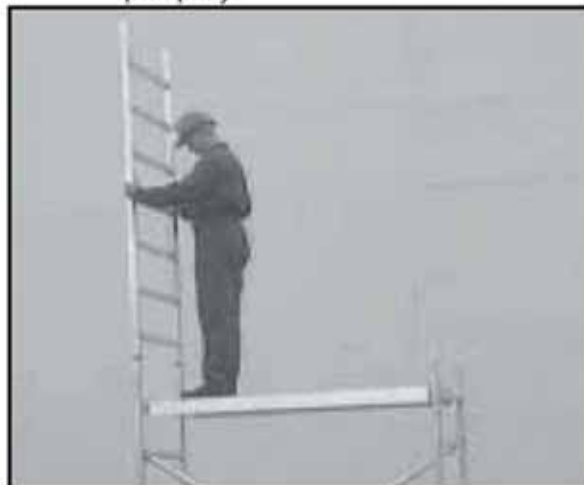
Obr. 22 Montáž nasazovacího rámu
